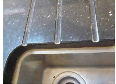
Limescale drainer grooves
